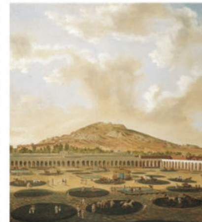
Imagen 1.13. Hacienda de beneficio de plata ubicada en la localidad Proaño, Zacatecas. En la imagen se observa el "método de patio".
