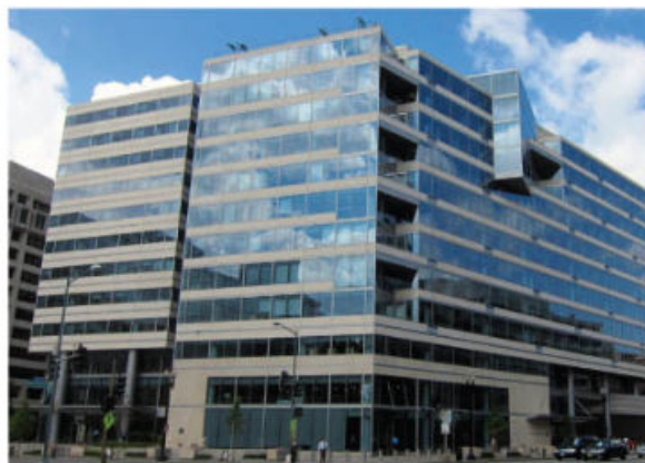
Imagen 5.6. Edificio sede del Fondo Monetario Internacional en Washington, E.U.A.
