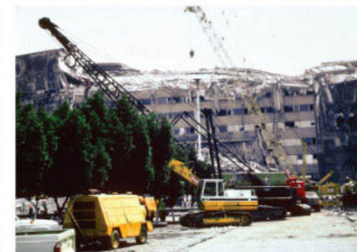
Imagen 5.21. Escombros del edificio de la Secretaría de Comunicaciones y Transportes en la Ciudad de México, colapsado durante el terremoto de 1985. Fotografía del Servicio Geológico de los Estados Unidos.
